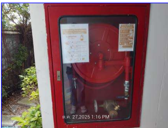
รูปที่ 2.33 ถังดับเพลิง และตู้สายฉีดน้ำดับเพลิง
