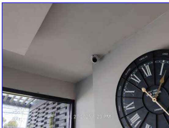
รูปที่ 2.26 ระบบโทรทัศน์วงจรปิด (CCTV)
