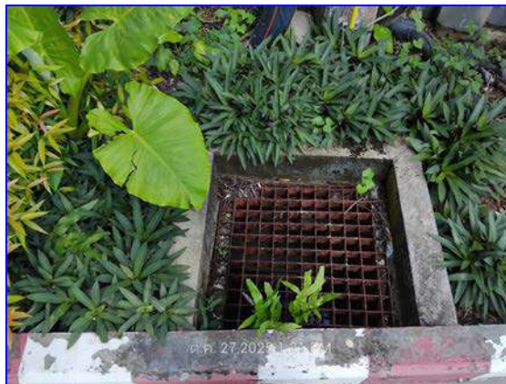
รูปที่ 2.41 ตะแกรงดักขยะ
