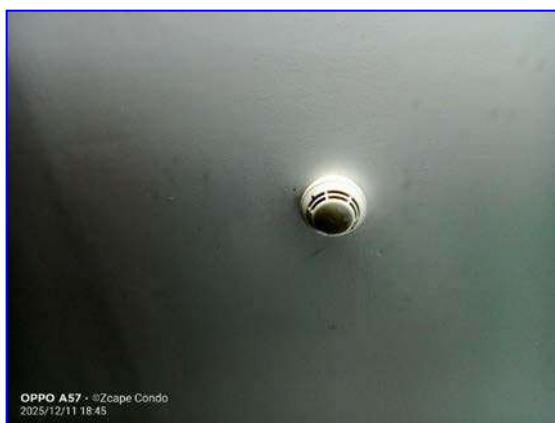
รูปที่ 3.38 อุปกรณ์ตรวจจับควัน
